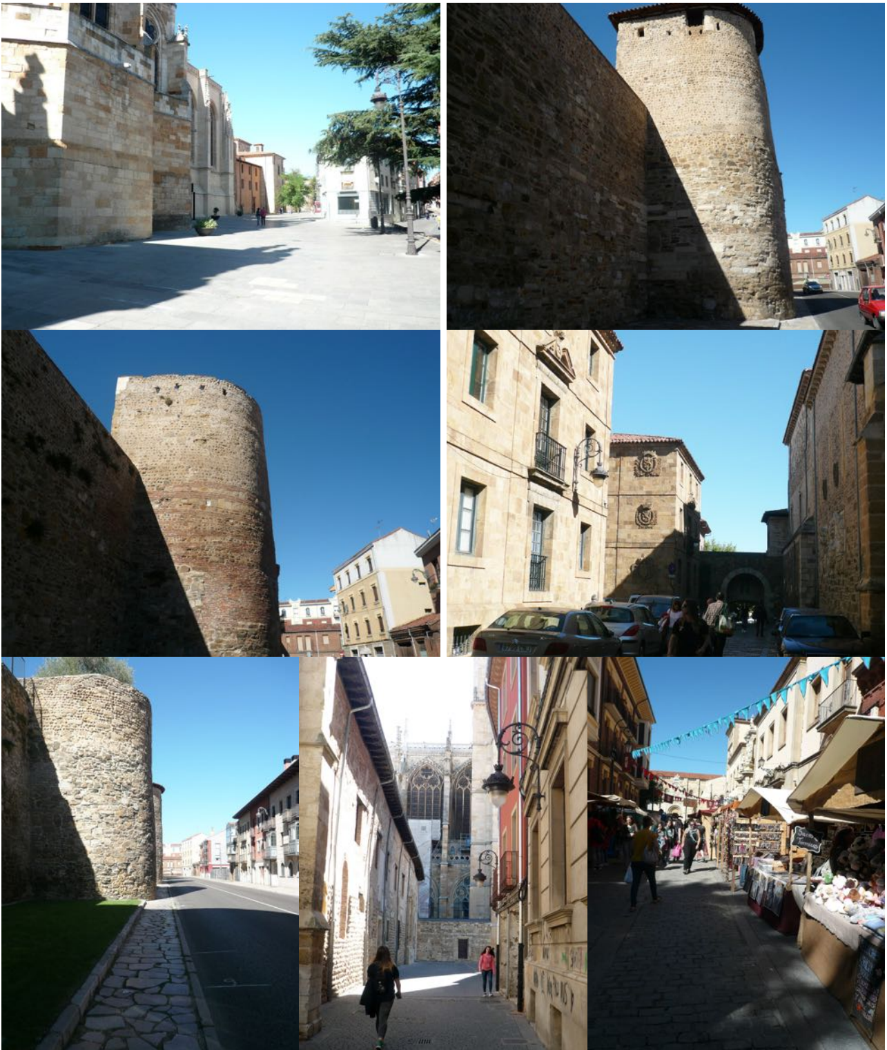
Foto 46-52. Camino 2018. Qui continua il mio pellegrinare lungo le vecchie mura turrite di León (la muralla). Murallas de León – La muralla romana de León tiene su origen en una primera fortificación militar de época augustea, en torno al siglo I a. C., y consistía en dos muros paralelos de madera rematados por un parapeto que estaban unidos por un entarimado. Pronto fueron sustituidos por una construida en piedra por la Legio VII en torno al siglo I, cuyos restos aún son visibles en la zona de San Isidoro. En torno a los siglos III y IV se construyó la que puede contemplarse hoy en día. Declarada Monumento Histórico Artístico en junio de 1931, aún quedan en pie muestras que encerraban el recinto de la ciudad en un cuadrilátero que fue rodeado de construcciones y más tarde deformado en las restauraciones de Alfonso V y Alfonso IX, con apertura de nuevas entradas a la ciudad. Está regularmente conservada desde la torre llamada de los Ponces (de origen también romano) hasta Puerta Castillo, y desde aquí hasta la torre de San Isidoro, en total casi la mitad del recinto, aunque con desigual estado de conservación. Se está procediendo actualmente a su restauración. En cuanto a las cercas medievales, su origen data del siglo X, y fueron construidas para
