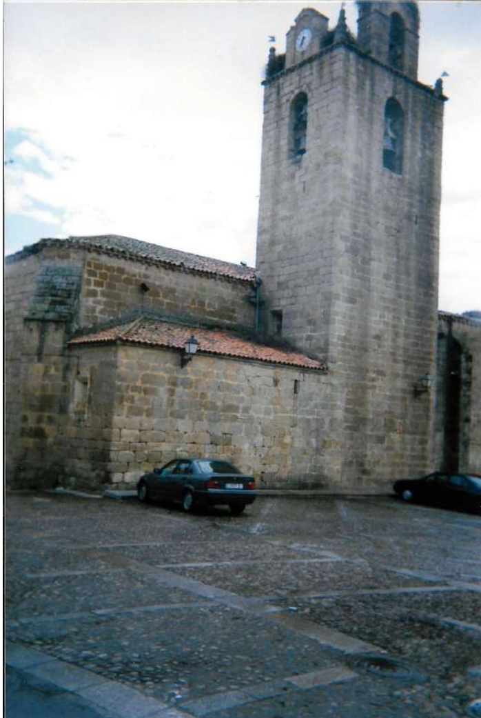
Foto 86-87. Camino 2003. Per entrare in Cañaverál, passo poco prima sul ponte medievale di San Benito del secolo XIV ( in alto ). Qui mi trovo davanti alla Iglesia Parroquial de Santa Catalina, costruita di certo nel secolo XIV e poi ampiamente rimaneggiata nel XVI ( in basso ).
