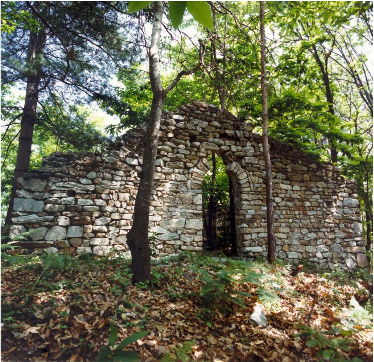
Foto 21, Rino Canavese. La facciata, rivolta ad ovest, e il portoncino di ingresso della Chiesa di sant'Andrea.
