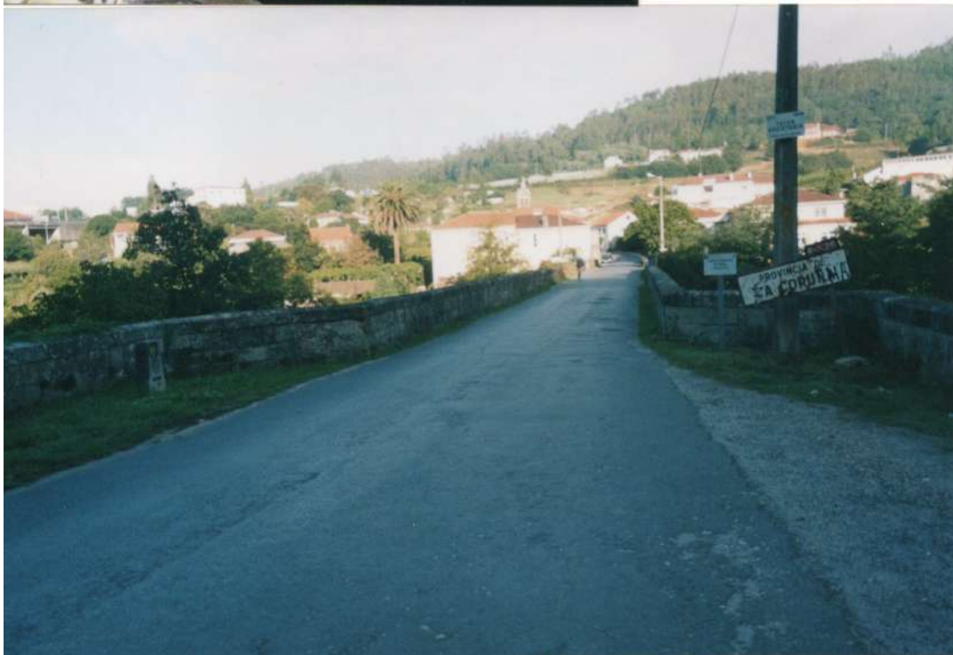
Foto 152-153. Camino 2004. Il ponte romano, chiamato “Ponte Taboada”, che dopo Prado attraversa il río Deso ( in alto ). Il ponte antico che, dopo l'attraversamento, porta nel centro di Puente Ulla ( in basso ).
