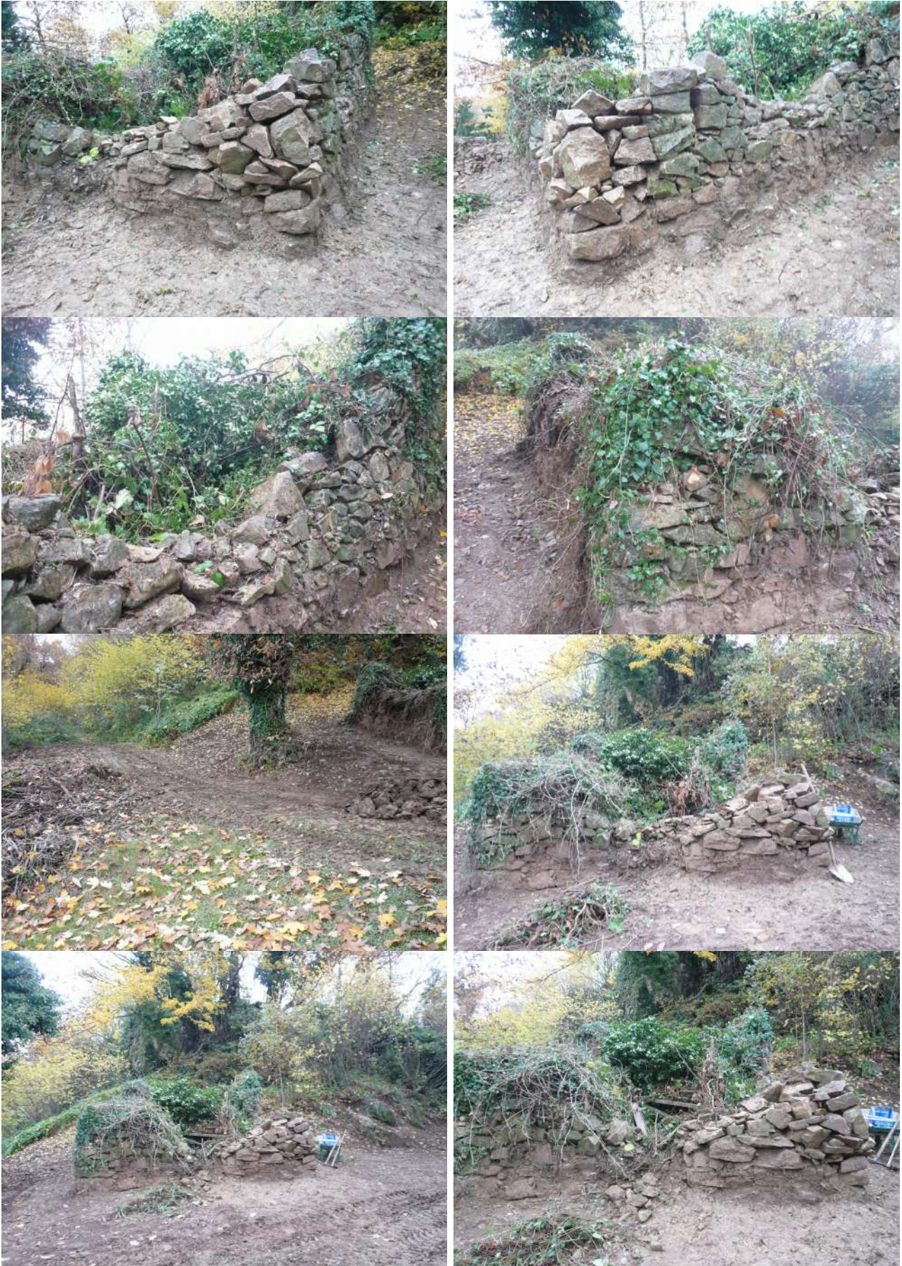
Foto 13-20. I ruderi dissepoliti con le travi in ferro arrugginito dell'antico seccatoio ( scóu in parlata chiusana).
